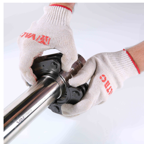
5. Снимаем пресс-кольцо.
