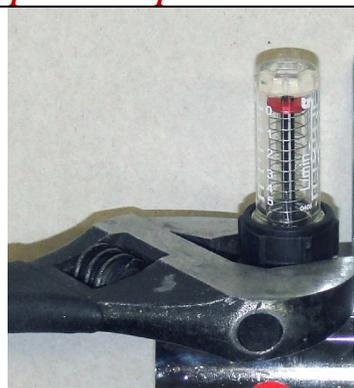
Для замены клапана открутите его от коллектора за латунную гайку
